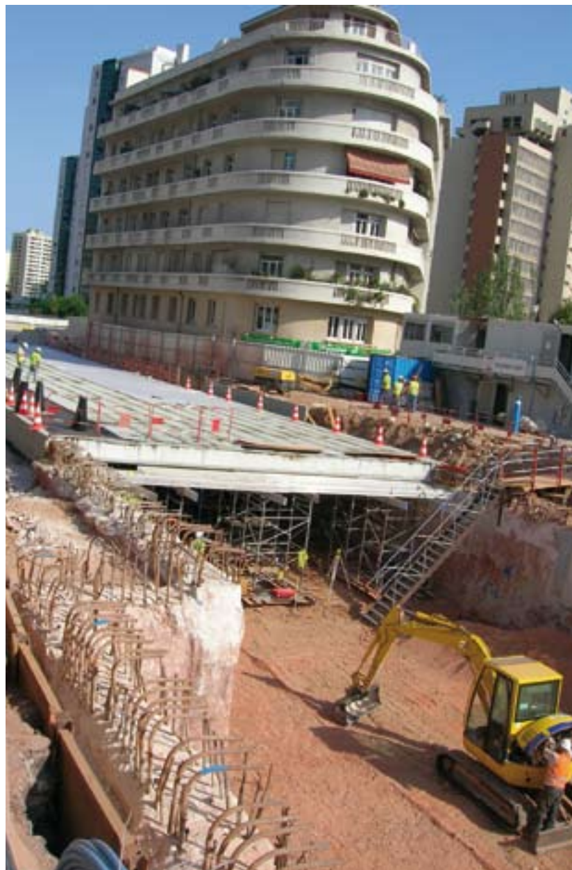
Entrée Est du 2 e tube - Tunnel de Toulon
