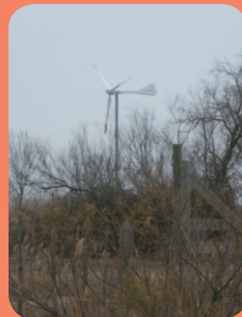
Petite éolienne installée en 2009 aux marais du Vigueirat (13)
