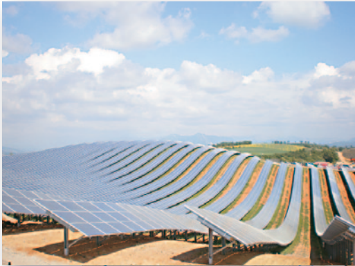
Le parc solaire des Mées (04)
